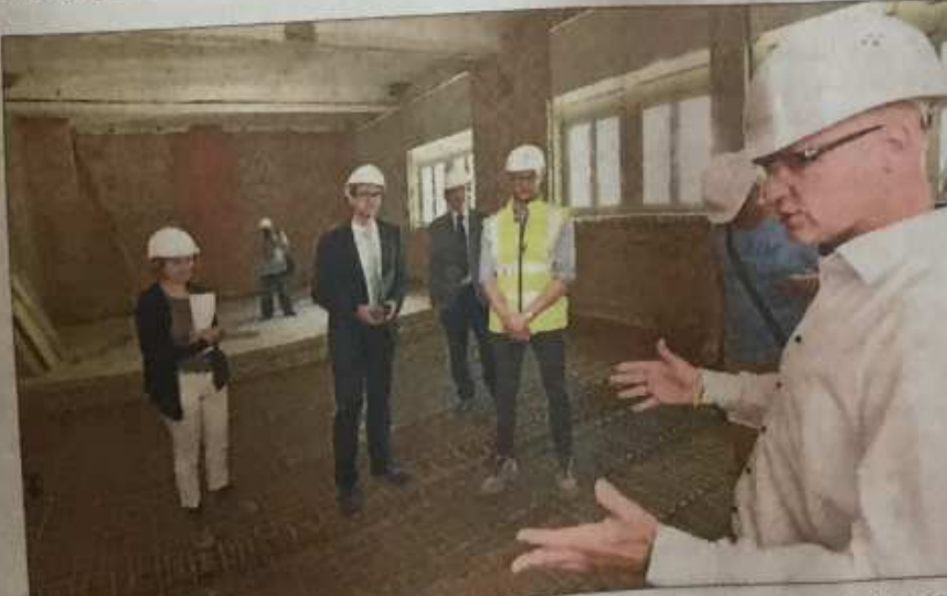
Dirk Dittmayer (r.) erklärt Jan Schneider (Dritter v. l.), wie der Betonboden gegossen wird. Die Gäste in der Elisabethenschule stehen auf Stahlflecht.
