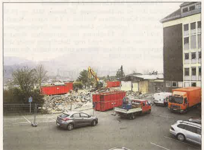
Bald schon entsteht auf dieser Freifläche der geplante Neubau zur Klinik
