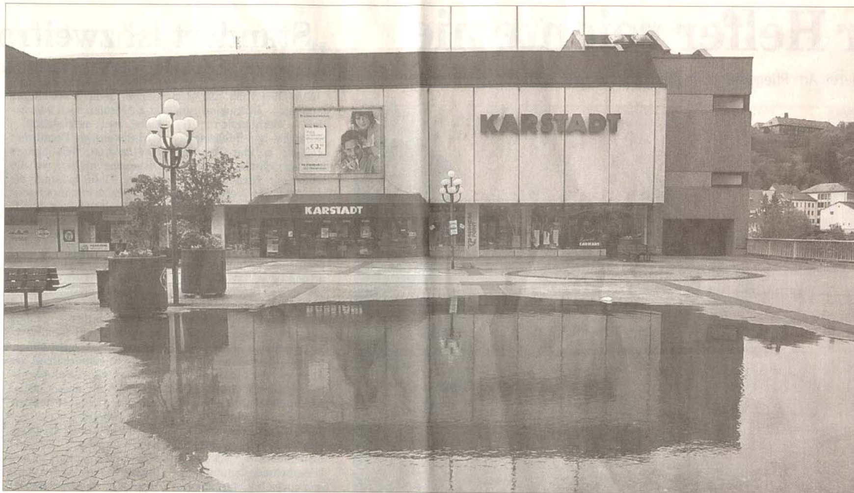
In nur vier Monaten soll der Platz Auf der Idar in neuem Glanz erblühen. Erst nach der Sanierung des Pflasterbelags und der damit verbundenen Abdichtung kann dann mit der Betonsanierung im maroden Parkhausdach begonnen werden. ■ Foto: Hossler
