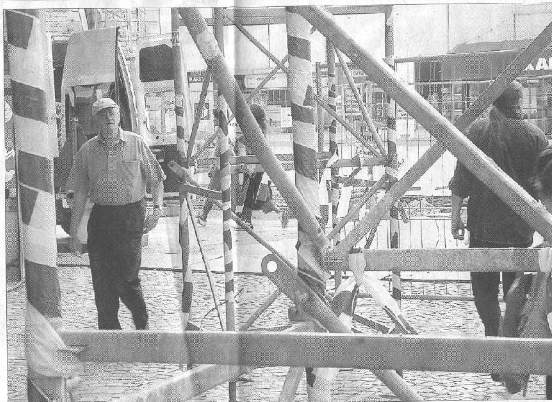
Verwirrung zwischen Gerüsten und Umgehungen: Die Sanierung des Platzes Auf der Idar sorgt für Unmut. ■ Foto: Thomas Reitzer
