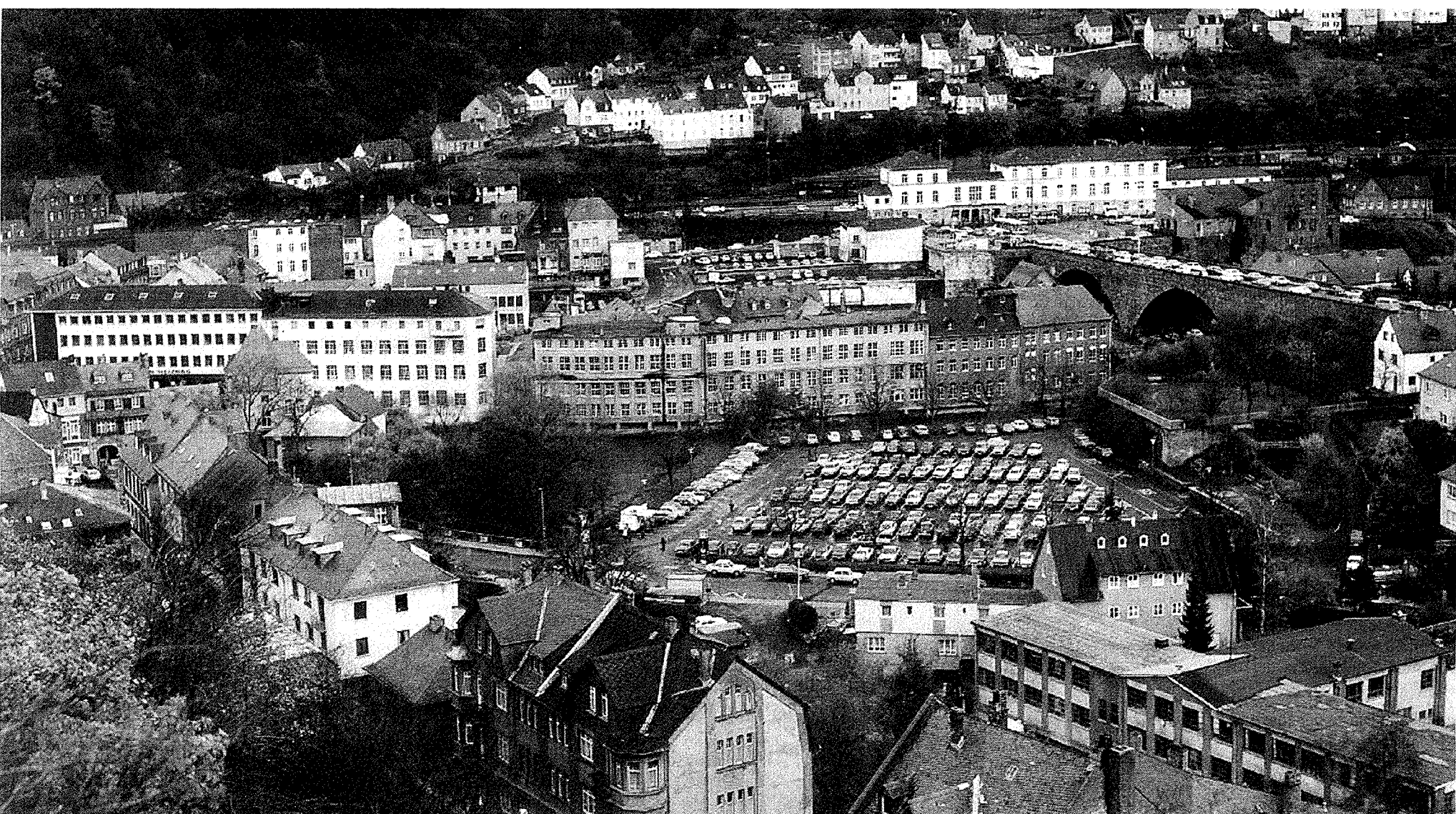
Es wird wie früher: Auf dem Platz Auf der Idar darf ab 1. April 2005 wieder wie einst geparkt werden. Im Parkhaus darunter sollen Veranstaltungen stattfinden. Foto: Hossler (Archiv)
