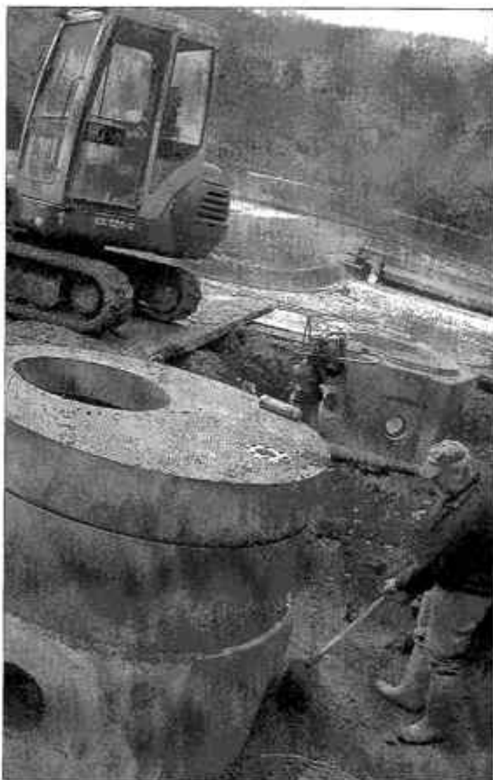
Rund zweieinhalb Monate soll die technische Erneuerung der Kläranlage in Frauenberg dauern. ■ Foto: Michael Werle
