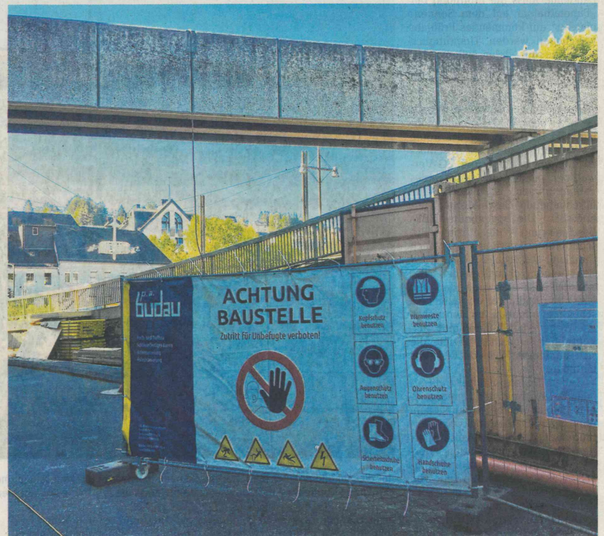
Die Baustellenvorbereitungen laufen auf Hochtouren. Zuerst wird am übernächsten Wochenende die Brücke abgerissen, dann der Kragarm am Röther-Gebäude.
