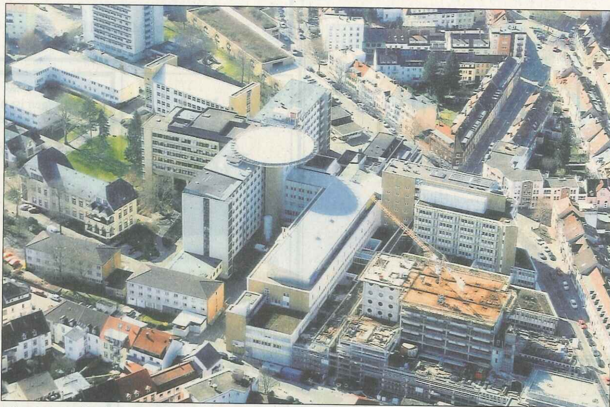
Schon bald fertig: die neuen Gebäude des Kaiserslauterer Westpfalz-Klinikums.
