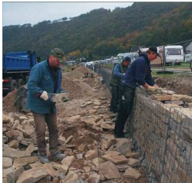
Eine etwa 70 Zentimeter hohe Gabionenmauer gleicht nach der Abgrabung des Geländes den Niveauunterschied aus und sorgt für eine Abgrenzung zum privaten Campingplatzgelände. Mit großer Präzision fügen die Maurer eines Spezialunternehmens die Steine zusammen.
