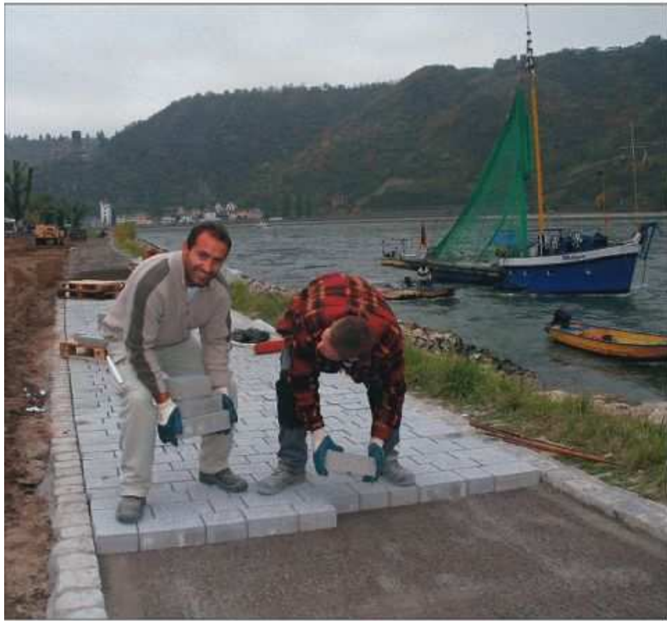
Der Leinpfad entlang des Rheins bei St. Goar mausert sich zur Promenade. Zurzeit sind die Pflasterarbeiten in vollem Gange, nachdem im Sommer immer wieder kleine Hochwasser die Arbeiten verzögerten. Das Boot erinnert an die Zeiten, als der Fischfang in St. Goar viele Familien ernährte. ■ Fotos (5): Suzanne Breitbach
