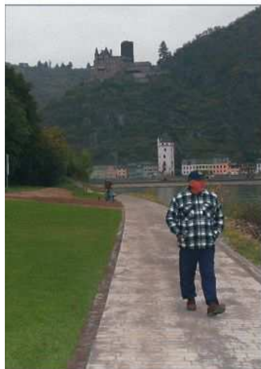
Im nördlichen Bereich kann man das fertige Werk bereits erahnen. Hier wurden rund 2500 Quadratmeter Rollrasen verlegt. Vor dem Panorama der Burg Katz lässt es sich schön flanieren.
