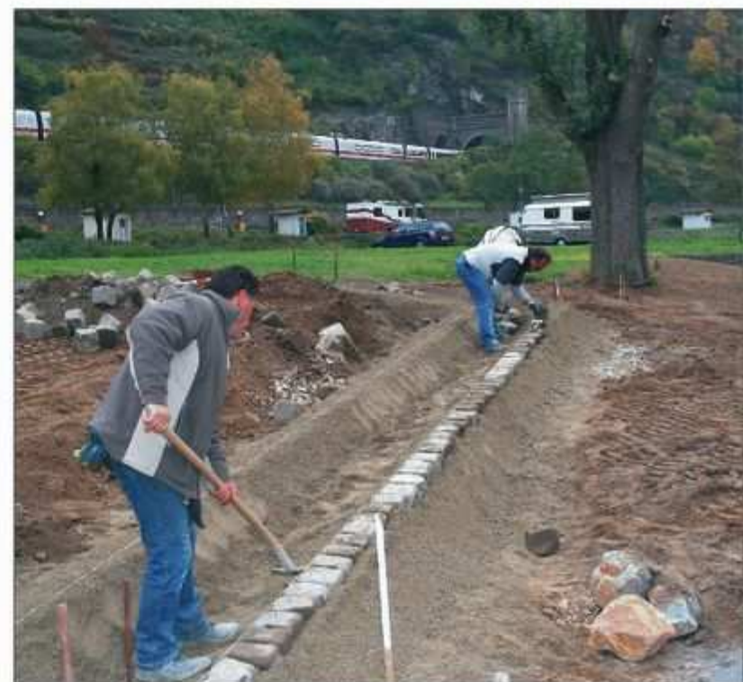
Das Gelände am Ufer erlebbar machen – das ist das zentrale Anliegen bei der Baumaßnahme, die rund 1,2 Millionen Euro kostet. Auf neuen Pfaden lässt sich Altbekanntes entdecken. Auch die Mündungsbereiche des Seelen- und des Galgenbachs treten wieder deutlicher in Erscheinung.
