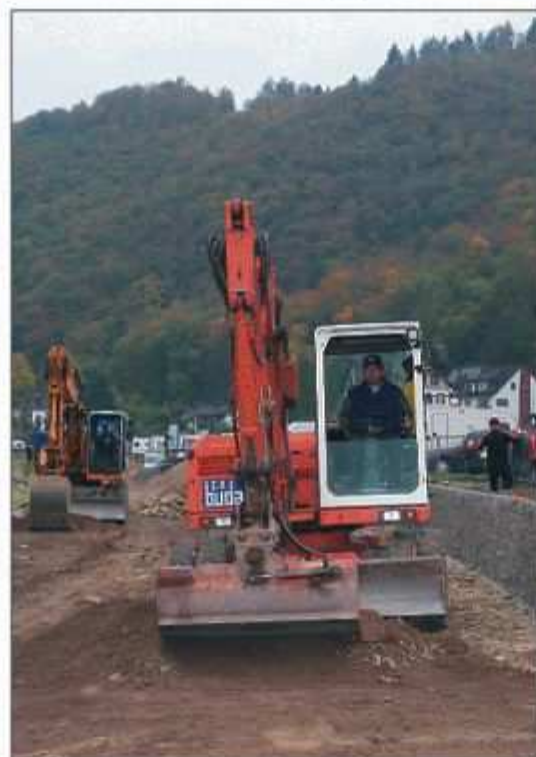
Weiter südlich sind die Bagger noch fleißig an der Arbeit. Nach Verzögerungen durch Hochwasser wird mit dem Ende der Bauarbeiten im kommenden Jahr gerechnet.
