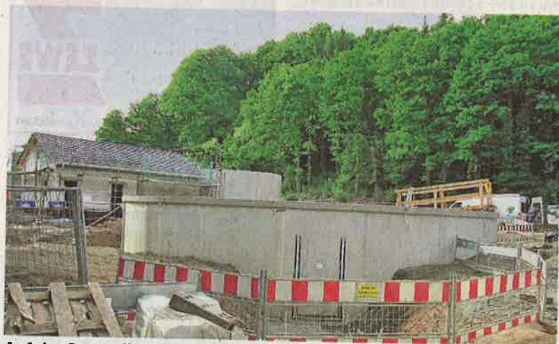
Auf der Baustelle: im Vordergrund das neue Klärbecken.
