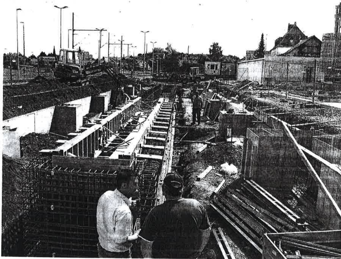
Blick auf die Baustelle der Saarbahn-Wartungshalle in Lebach-Jabach. Im Vordergrund spricht Stefan Speicher von der Bauüberwachung (links) mit dem Polier der Firma Budau, Gerhard Sauter. Rechts ist das Sozialgebäude zu sehen. FOTO: FRED KIEFER
