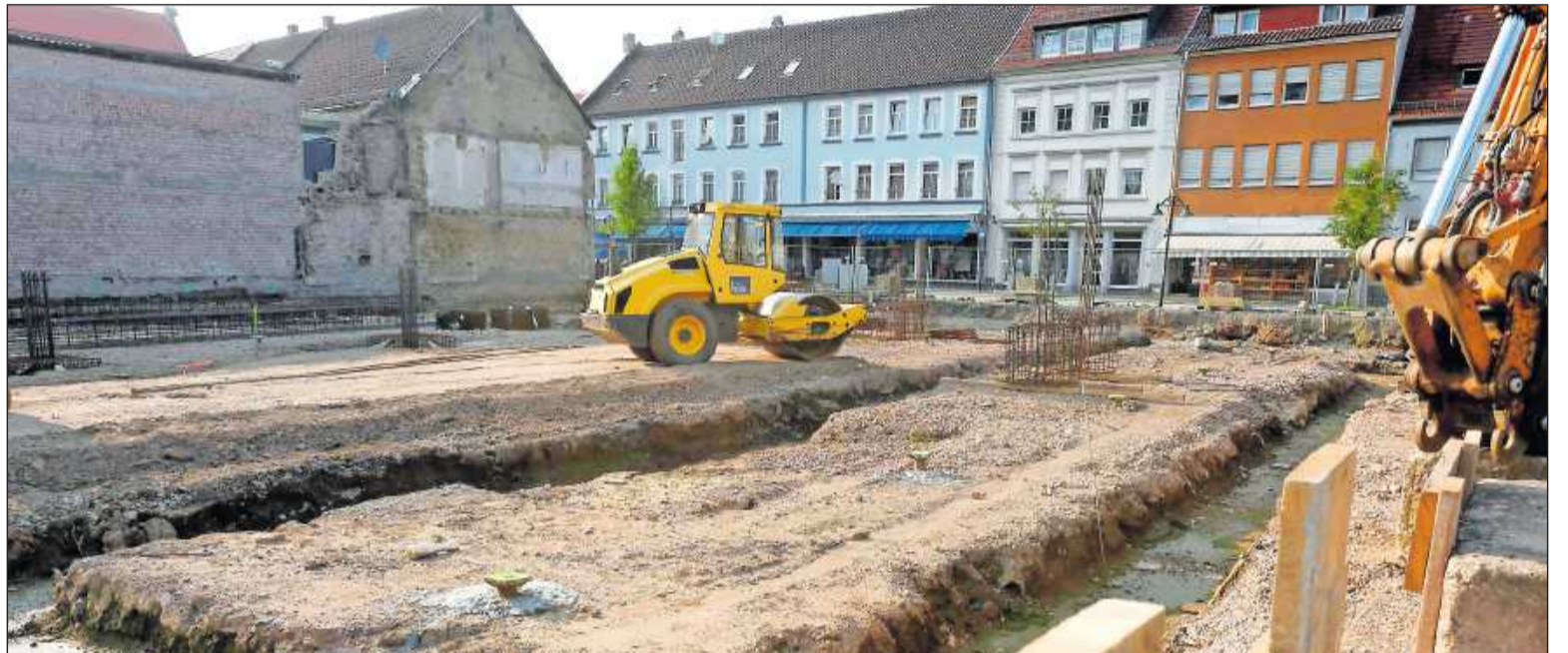
Mit der Bodenplatte geht es los. Vier Jahre nach dem Kauf fängt die Firma Budau an zu bauen. FOTO: SAYER
