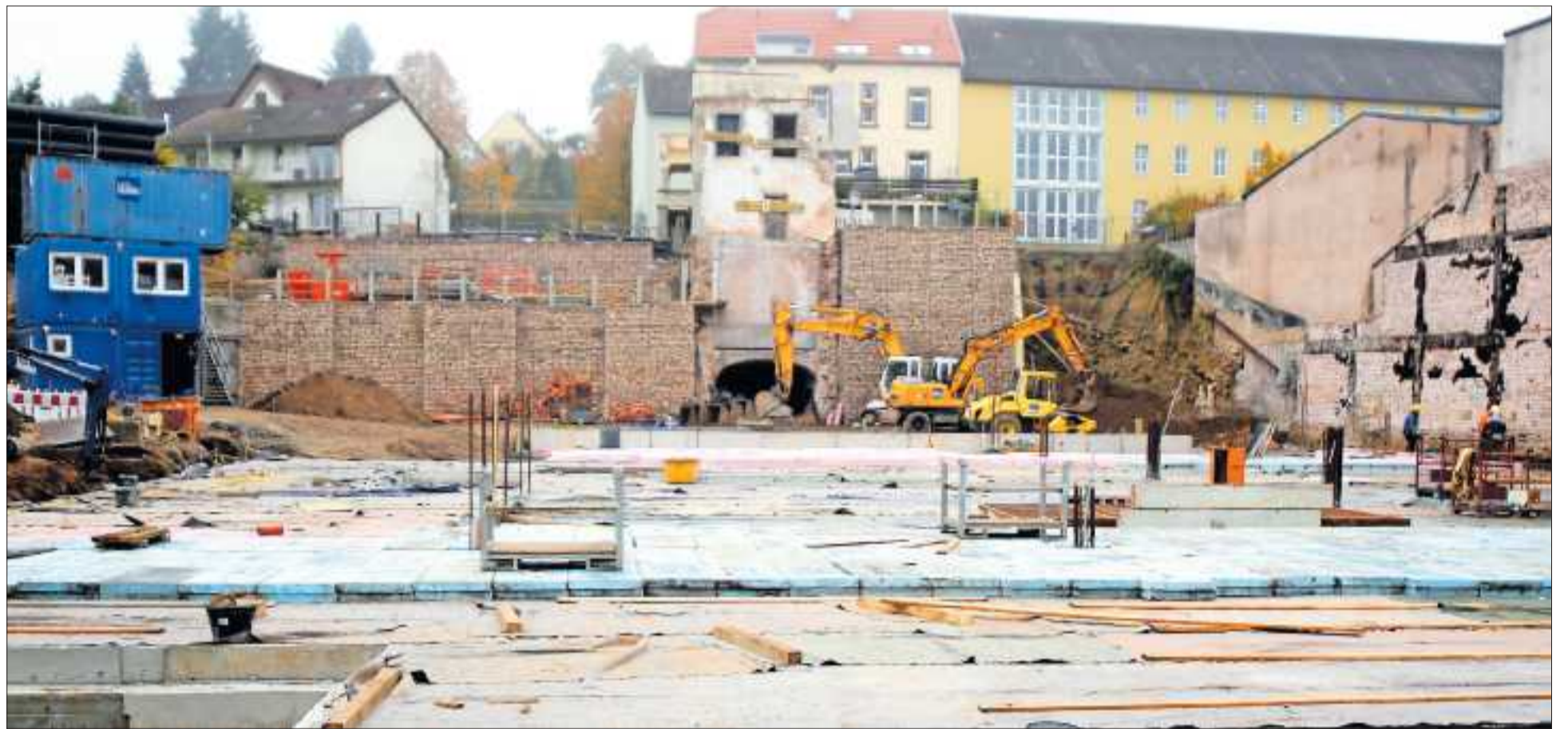
Die Bodenplatte in der Bahnhofstraße wächst täglich.
